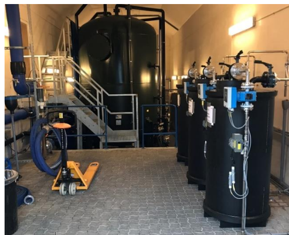
Figur 3. Pilotkolonner med på Hvidovre vandværk med polymeriske resiner (Resinex AD-3015 og Resinex AD-3004) samt med alm. GAC-kul (AquaSorb CS).
