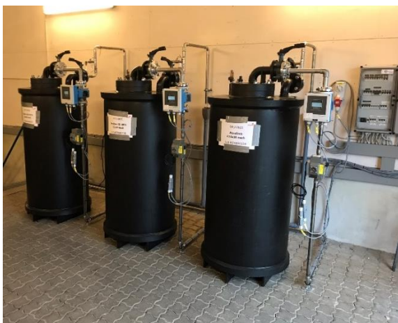
Figur 3. Pilotkolonner med på Hvidovre vandværk med polymeriske resiner (Resinex AD-3015 og Resinex AD-3004) samt med alm. GAC-kul (AquaSorb CS).
