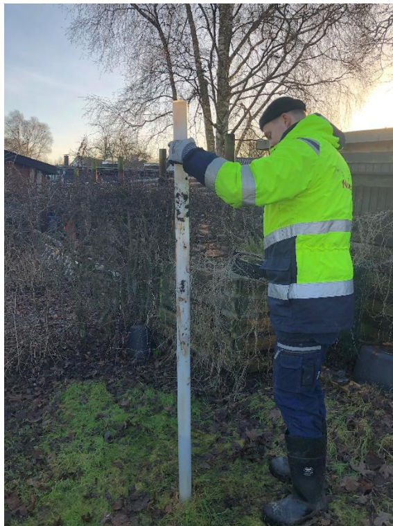
Figur F6: Optrækning af rør.
