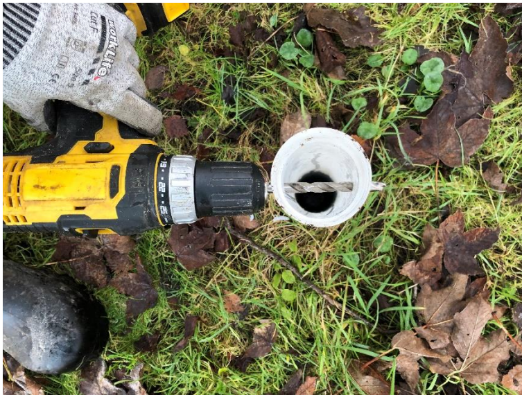
Figur F3: Etablering af hul i rør.
