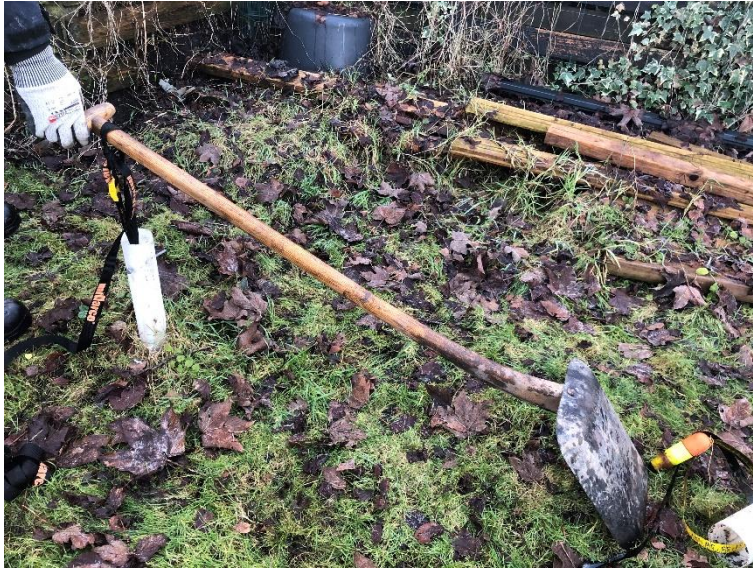
Figur F5: Løftesystem til løsrykning af rør.
