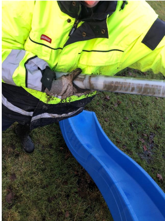
Figur F7: Adskillelse af filterrør og blindrør.
