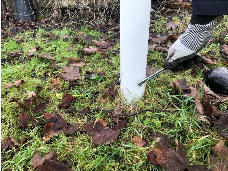
Figur F1: Løsning af bolte på pejlehoved.
