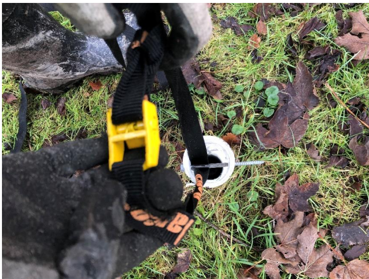
Figur F4: Montering af løfteøje til optrækning af rør.
