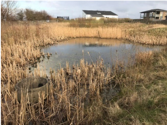
Billede 2: Foto af regnvandsbassinet på Gefionsvej i Lemvig ved Lemvig Forsyning.
