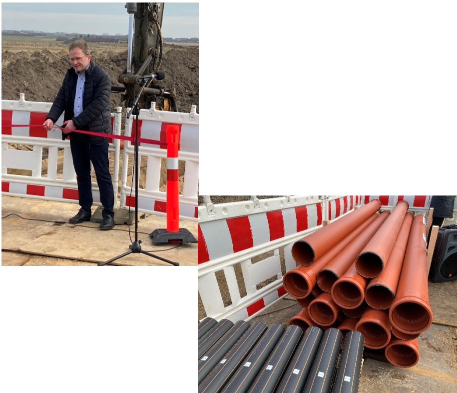
Figur 5.2-1 De udviklede pilotrør og nedlægningen 16/3 2022
