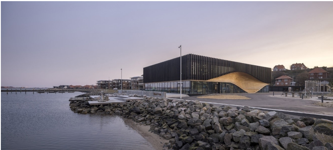
Figur 4.4-2 Klimatorium. Danmarks internationale klimacenter, med en besøgsantal på over 15.000 klimaturister årligt.
