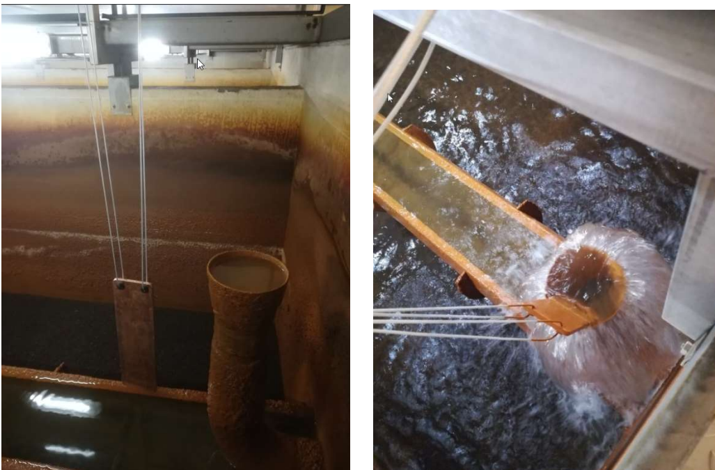
Figur 1 Tilsætning af kobber til Filter 3, Østerby Vandværk.
